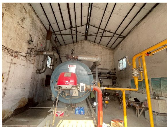
厂区现有工程燃气导热油炉
